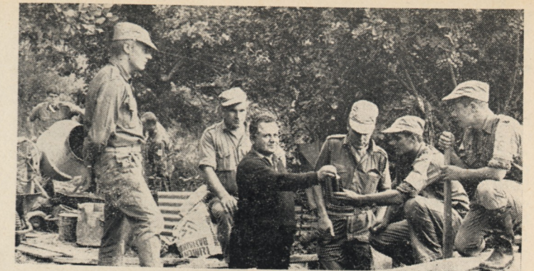
Rakennustoimintaa Tjikloksessa. Majoitusolot Tjikloksessa tulevat paranemaan. Kuvassamme peruskiven muurauksen alkuvaiheita.
